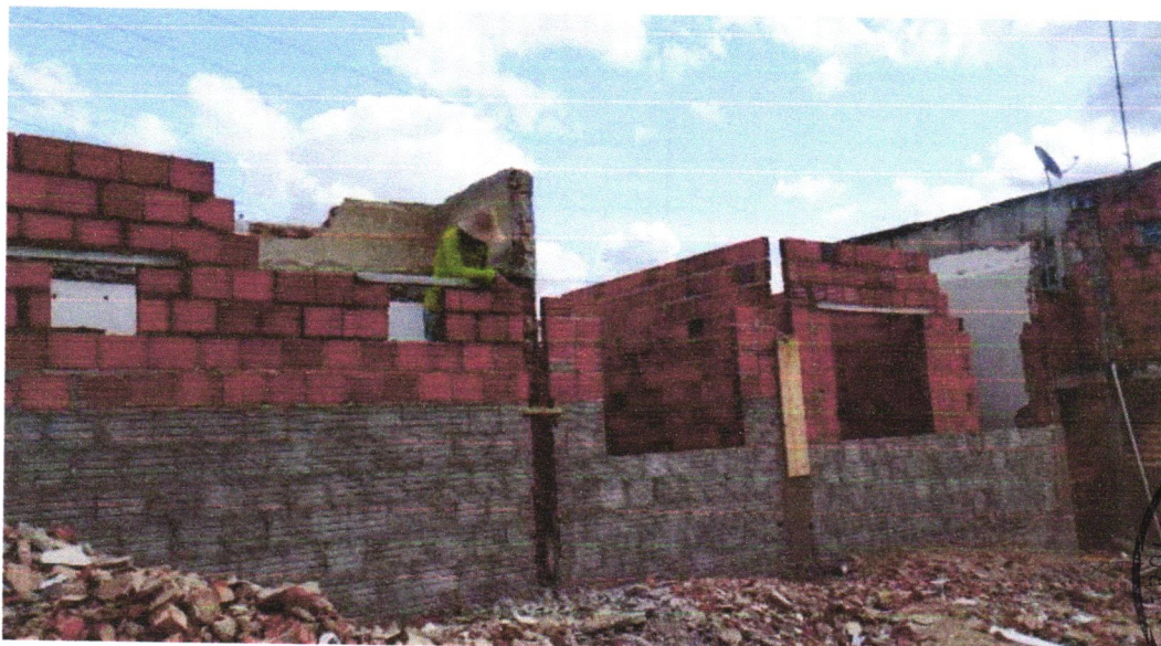
FOTO 08 – CHAPISCO APLICADO EM ALVENARIA (COM PRESENÇA DE VÃOS) E ESTRUTURAS DE CONCRETO DE FACHADA, COM EQUIPAMENTO DE PROJEÇÃO. ARGAMASSA TRAÇO 1:3 COM PREPARO EM BETONEIRA 400 L. AF_06/2014
